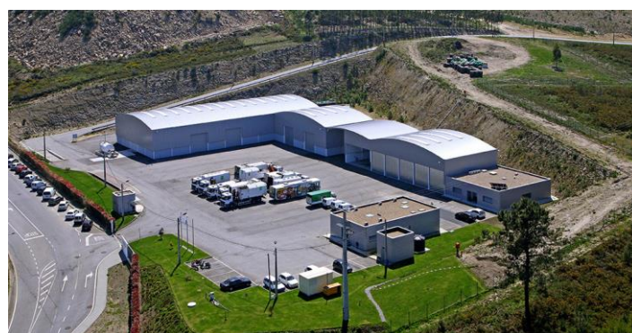
Figura 4– Centro de Triagem e Serviços Administrativos.
